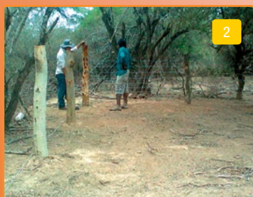
2. Cerramiento hoyado, posteo y alabrado para el cerramiento perimetral de la parcela.
